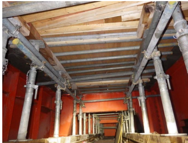
④床版型枠設置
