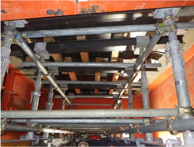
①床版裏面を鉄板養生
