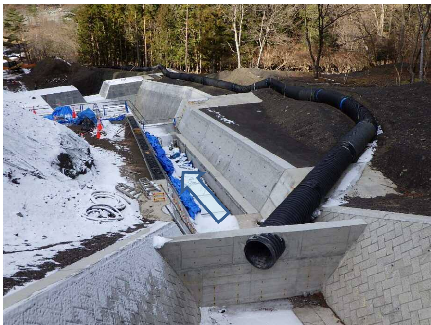
【上流側より側壁箇所を望む】（側壁設置箇所）
