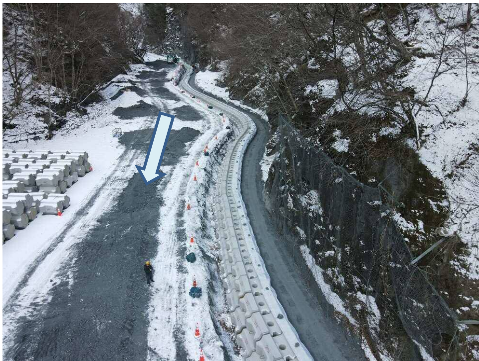
根固めブロック設置状況
