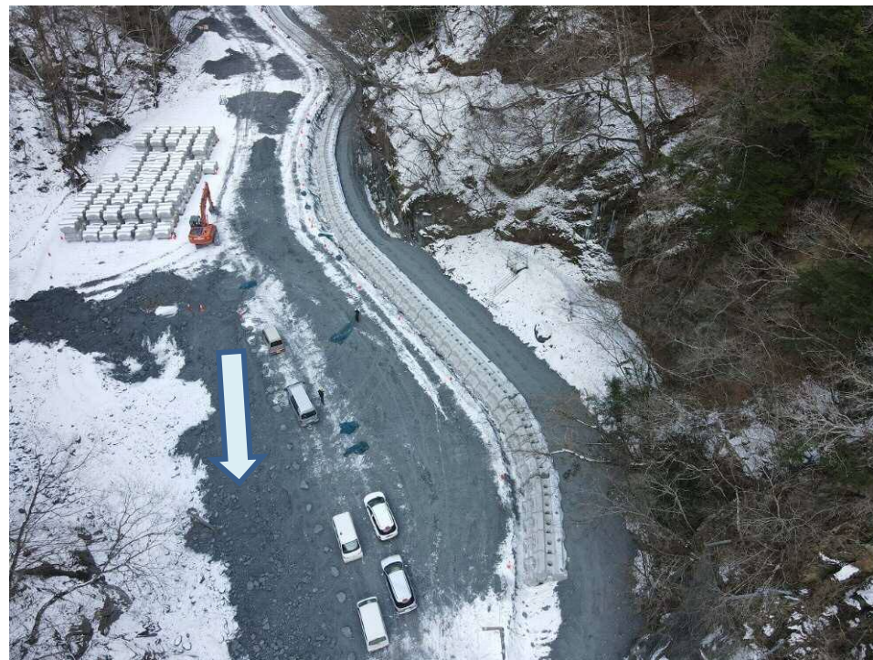
根固めブロック設置状況
