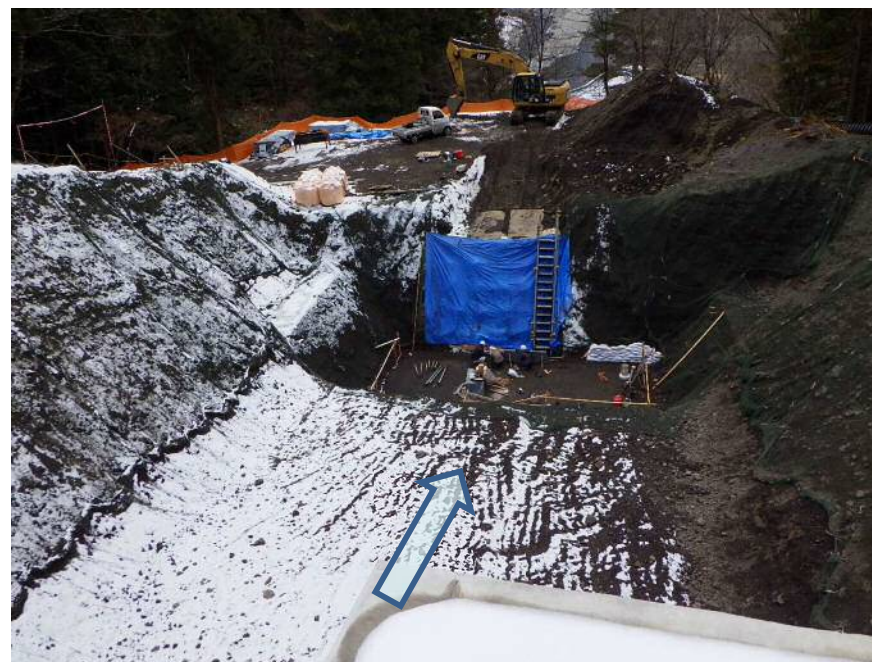
【上流側より施工箇所を望む】（堰堤設置箇所）
