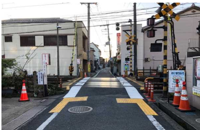
視覚障害者誘導用ブロックを 設置している事例 (奈良県大和郡山市)
