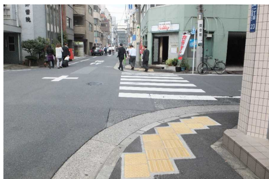
隅切のある歩車道境界での誘導用ブロック設置事例
