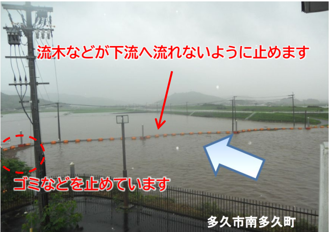
牟田辺遊水地（多久市南多久町）の貯留状況 (7/13 15:30頃) 写真: 網場の稼働事例(牟田部遊水池) 出典 九州地方整備局ホームページ
