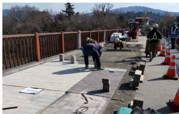
ブロック舗装の施工状況
