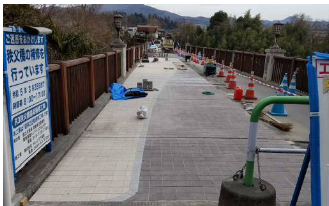
左岸側から望む (①写真)
