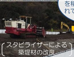
〔スタビライザーによる築堤材の改良〕
