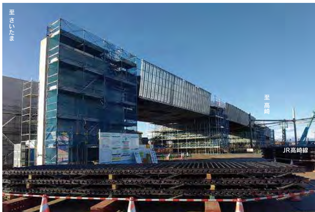
JR 高崎線交差部の橋梁上部工事の状況 (令和4年12月撮影)
