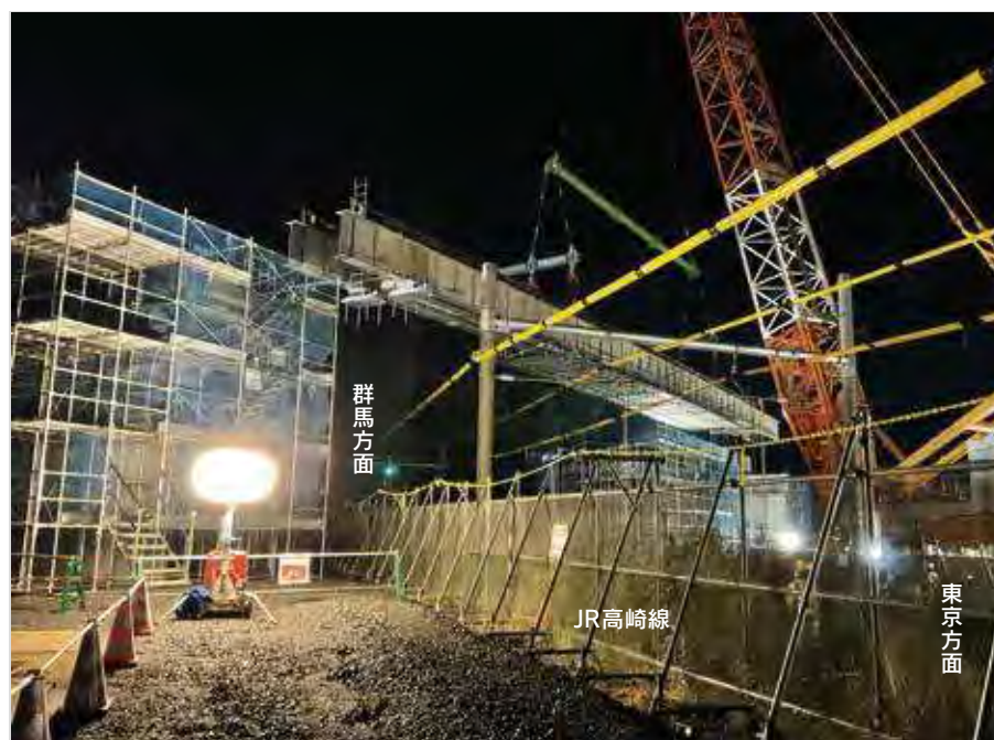
JR 高崎線交差部の橋梁上部工事の状況 (令和4年10月撮影)
