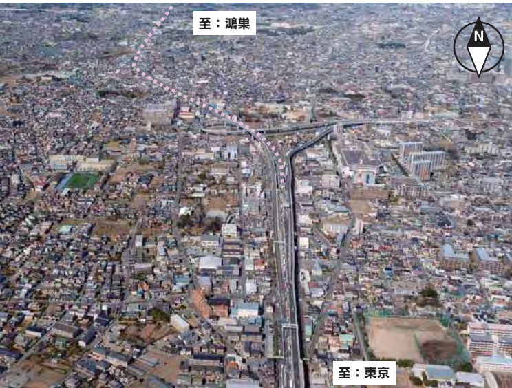
与野 JCT（仮称）付近
