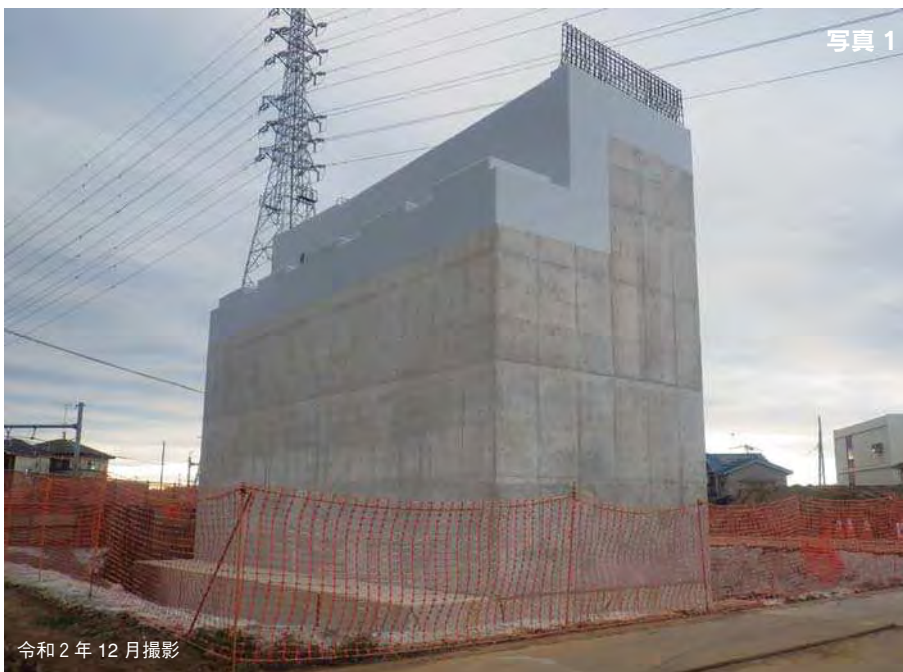
延長約100mの橋梁を支える柱（橋脚・橋台）4基のうち、1基について地中に打つ杭と橋台を造る工事を進めています
