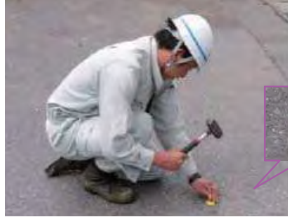
幅杭の設置状況（イメージ）
