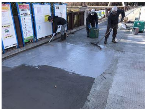
橋面の防水工事の状況
