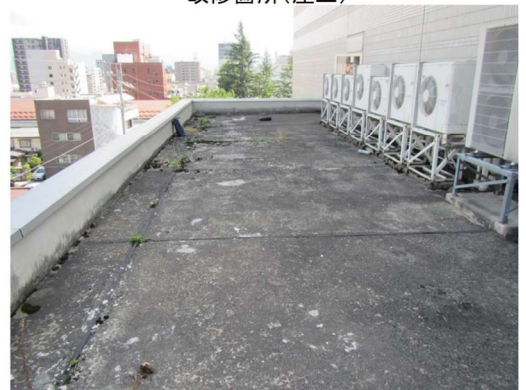
改修箇所(2階屋上)
