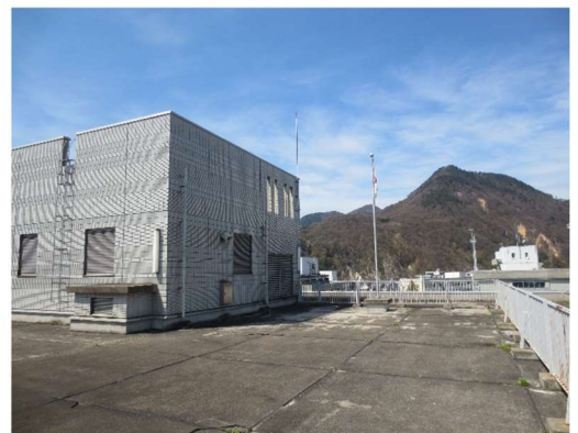
改修箇所(屋上)
