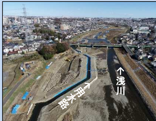
水路を迂回させています。 (令和4年12月)
