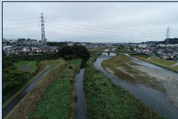
工事着手前 (令和4年10月)
