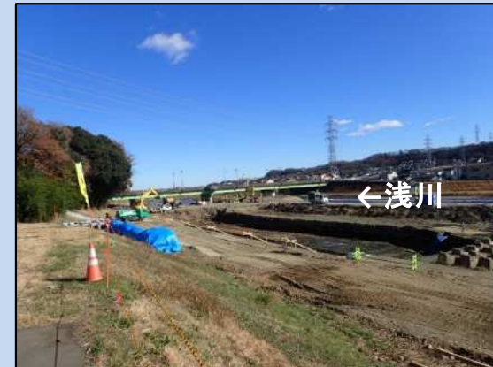
施工箇所を整えています。 (令和4年12月)
