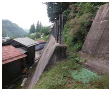
写真 107-1 中之条町根広地区にあるがけ崩れの危険箇所指定看板とがけ崩れ防止のための施設（擁壁工）
