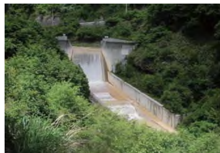
写真104-4 湯川砂防堰堤（不透過型）
