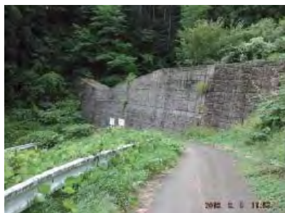
写真104-3 八幡沢砂防堰堤（不透過型） 高さ14.0m、堤長77.0m
