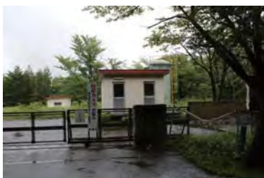
写真85-1 草津町の第一浄水場の建物 ここに第一配水池もあります。
