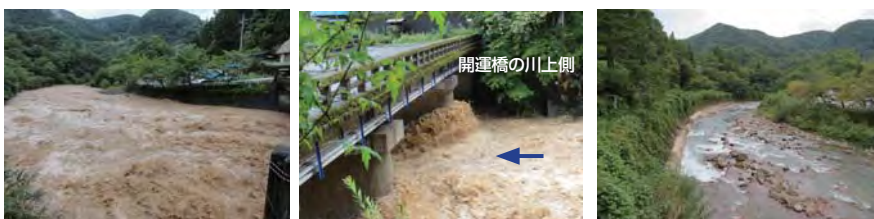
写真13-4 花敷温泉の開運橋から川下を見たところ(左・右) 開運橋の橋げたにはげしく当たる、にごった流水のようす(中)
