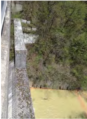
写真105-1 谷沢川第四砂防堰堤 (不透過型) 高さ27.0m、堤長88.8m
