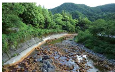
写真 106-1 花敷床固工群
