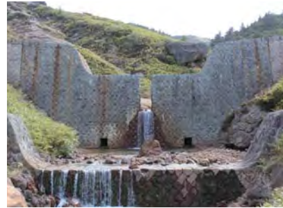
写真105-3 万座砂防堰堤 (透過型)
