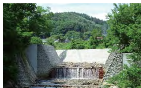
写真 106-4 おおさき 遅沢川（吾妻川の支流）の床固工群（渓流保全工）
