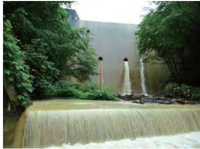
写真105-2 大沢川砂防堰堤 (不透過型) 高さ26.0m、堤長67.0m
