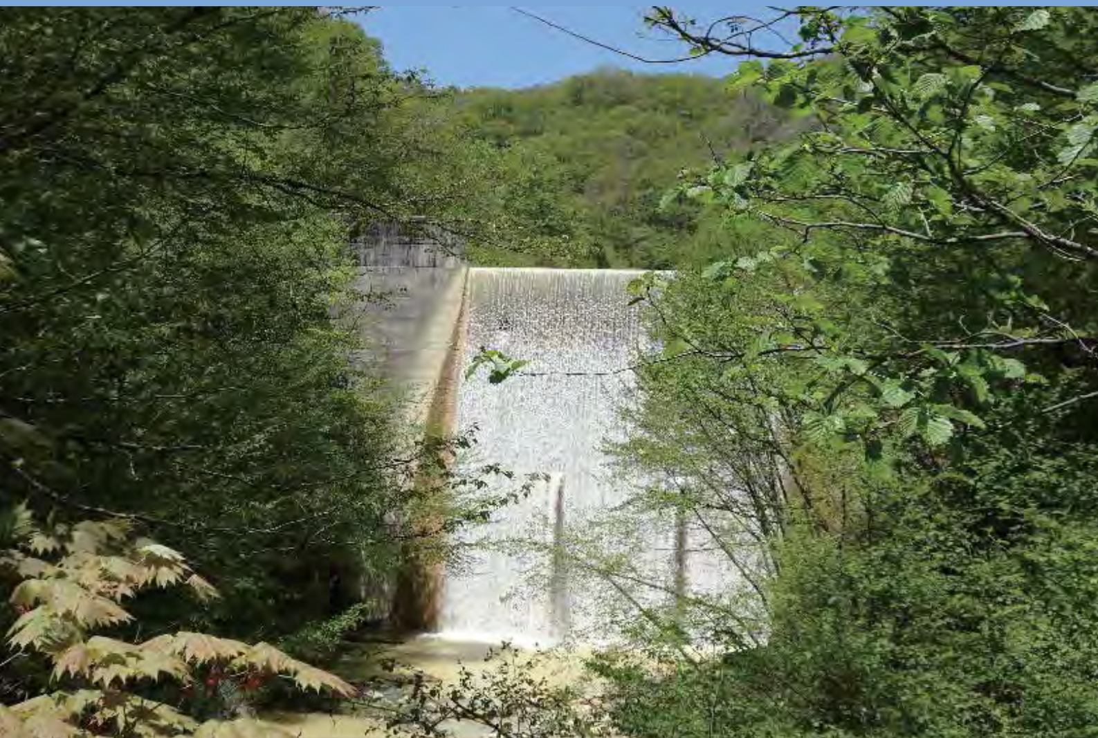
大沢川砂防堰堤（草津町と六合地区の境、大沢橋のすぐ上流）
