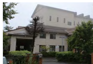
写真 88-1 草津町クリーンセンター
