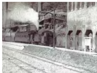
写真66-1 完成したころの太子駅
