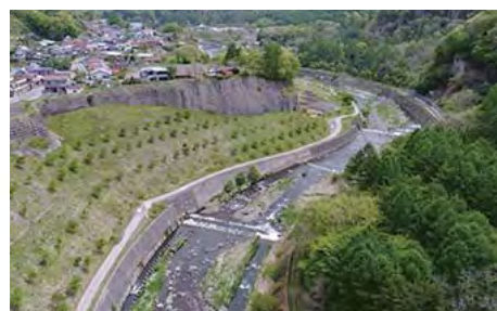
写真 106-3 つまごい おおさき あがつま 嬬恋村大前の吾妻川本流の床固工群（渓流保全工）
