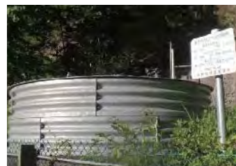
写真108-1 地すべり対策事業で整備された集水井 (六合中学校運動場の北側)
