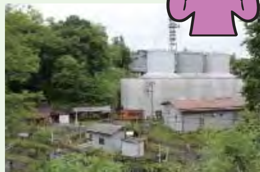
写真110-1 草津中和工場
