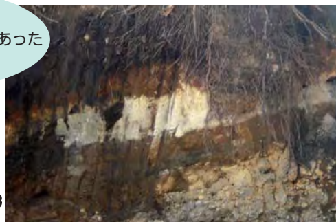
写真 22-4 地蔵の湯のはす向かいの工事斜面 (旅館たむら正面の土地の切り土斜面)
