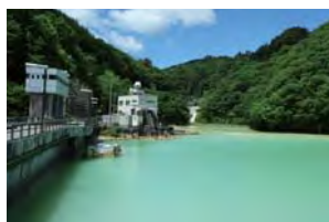
写真68-2 品木ダム（正面） 奥は湯川の上流方向） 湯川発電所は、このダムから 発電用の水を取っています。
