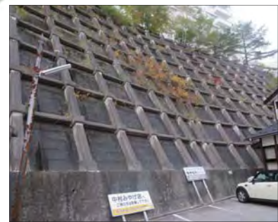
図 107-2 草津町泉水地区で昭和57(1982)年にがけ崩れ災害が発生した場所につくられたがけ崩れ災害を防ぐ施設（法枠工）(99ページも見てみよう)
