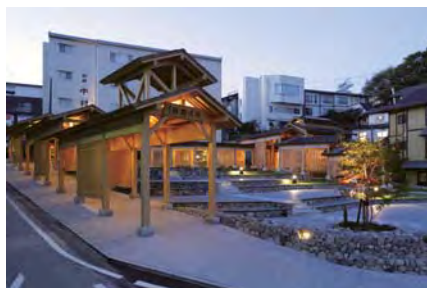
写真69-2 湯路広場 かつて湯畑のとなりにあった駐車場をほかの場所に移し、昭和初期の街並みをイメージした広場をつくりました。
