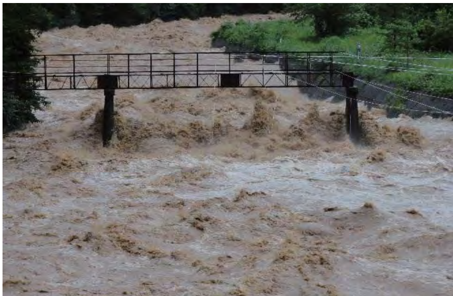
写真92-1 台風通過時の白砂川の濁流 だくりゅう （2011年9月4日 台風12号） 京塚温泉の京塚橋から川上を見えています。
