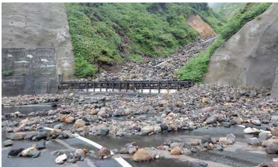
写真92-2 台風通過時の国道292号 ふり こ ざわおう か ぶ （振子沢横過部）の土石流被害 （2017年8月7日 台風5号）礫の割合が多い土砂が流下したい積しています。
