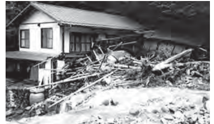
写真93-2 平成12(2000)年、台風の大雨で発生した土石流の被害(長野原町川原湯温泉) 吾妻川で土石流が起こり、家が土砂や流木でこわされたりしました。
