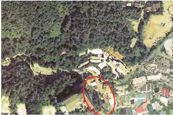
写真99-1 崩れたがけと土砂がたまった範囲
