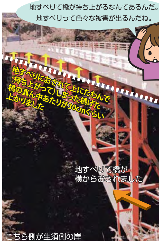
写真 100-2 龍宮橋が持ち上がったようす
