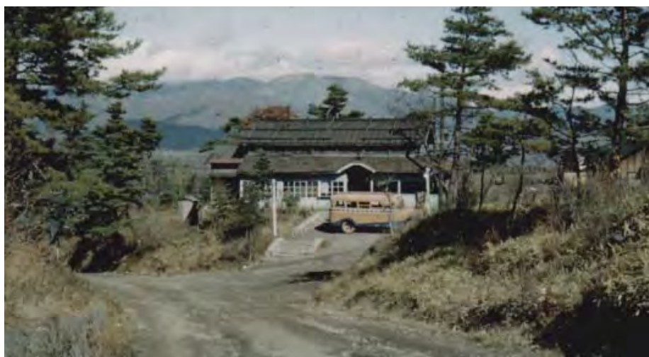
写真82-1 むかしの草軽電気鉄道草津温泉駅の駅舎
