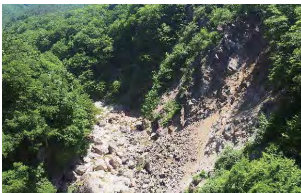
写真97-3 白砂川本流の小雨地区上流付近で見られるがけ崩れと河床の土砂
