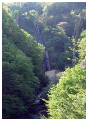
写真68-1 矢倉発電所の施設
