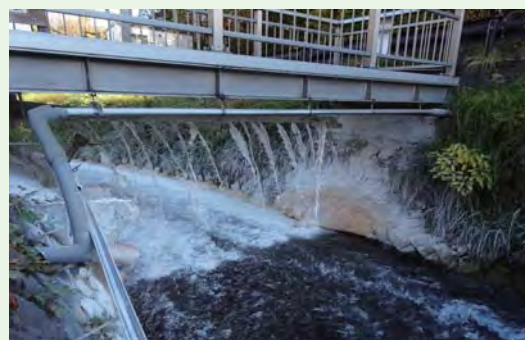
写真110-2 中和剤（水にとかした石灰石粉）を湯川に投入するようす
