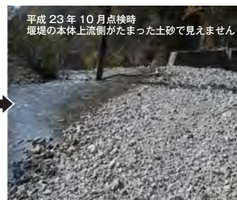
写真104-1 白砂川第3砂防堰堤の、土砂がたい積する前（左）とたい積したあと（右）
