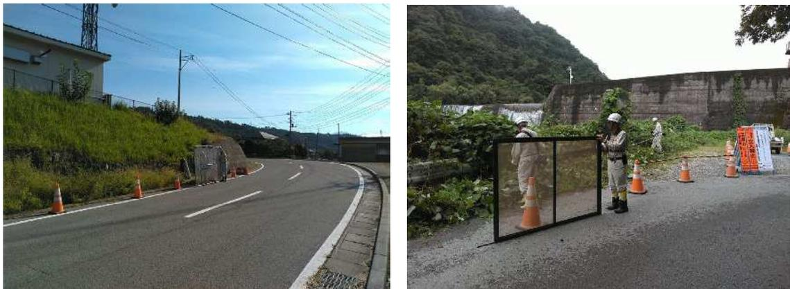
写真-5 ガードフェンスを使用しての除草作業状況
