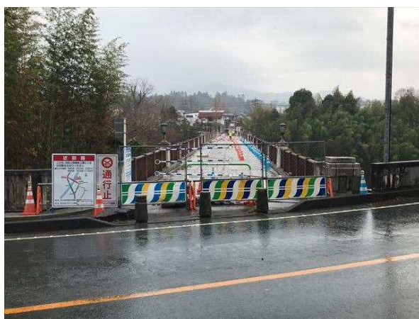
左岸側から望む (①写真)
