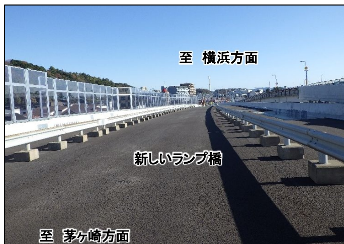
①工事実施状況
