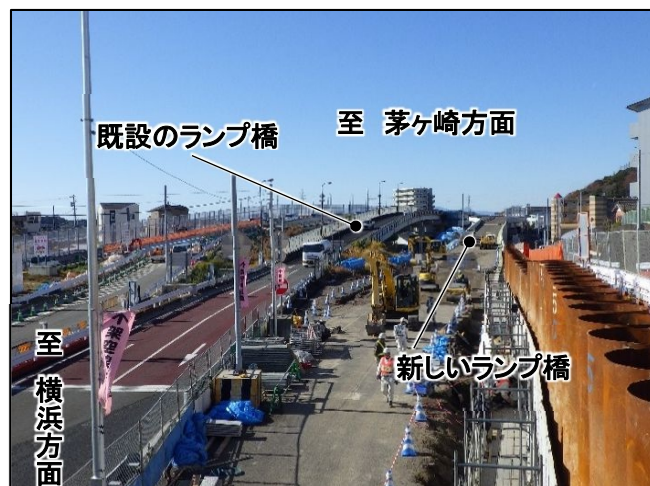
②工事実施状況
