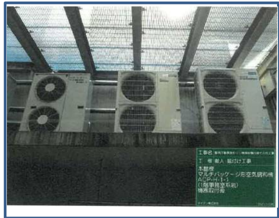
室外機 設置完了
