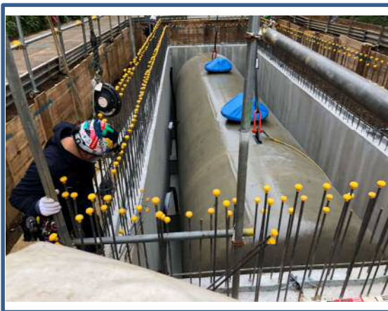
地下タンク施工状況
