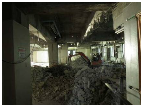
拘留室の隔壁解体状況
