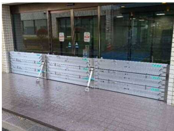
脱着式止水板 完成
