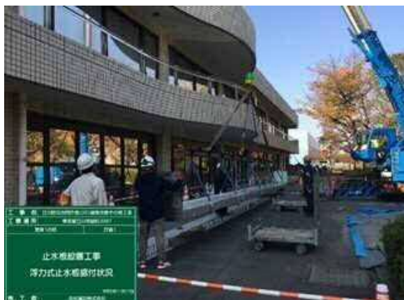
浮力起伏式止水板 施工状況
