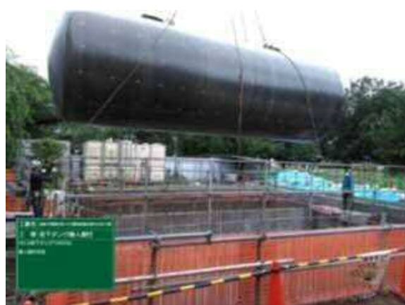
新設地下タンク据付状況
