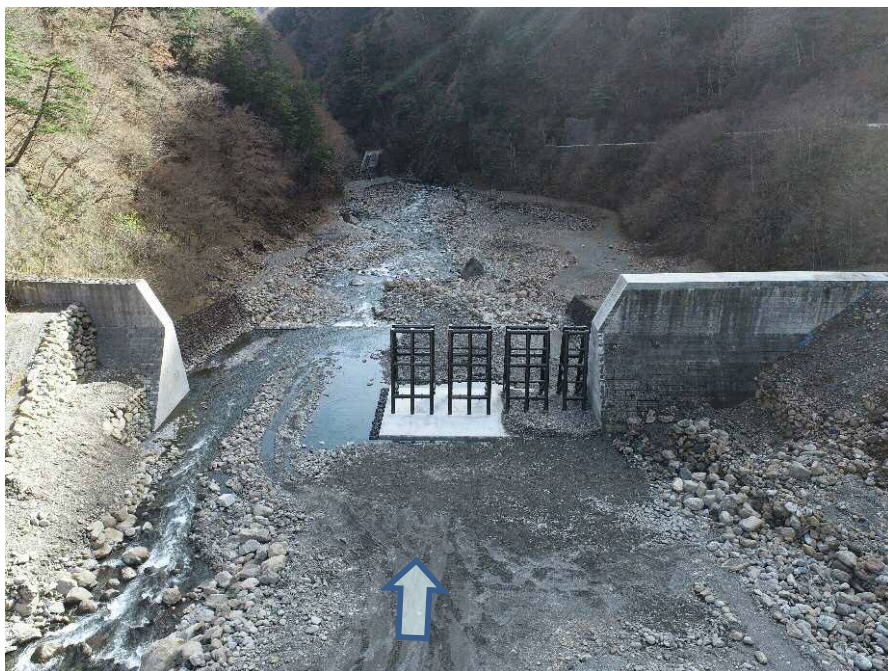
【上流側上空より施工箇所を望む】
