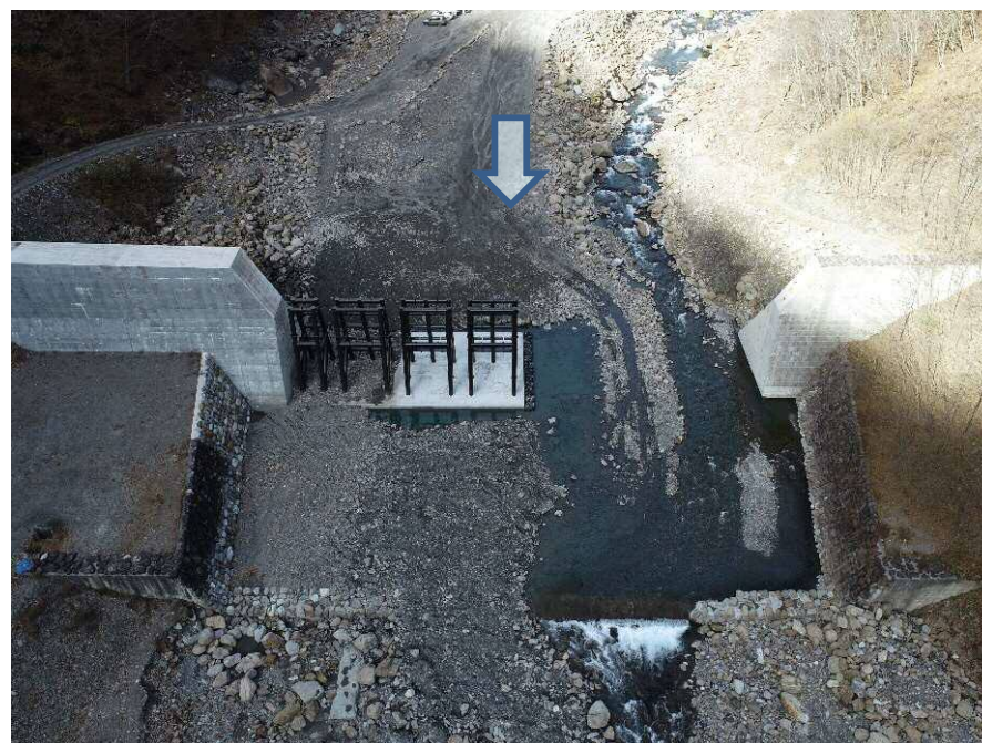
【下流側上空より施工箇所を望む】
