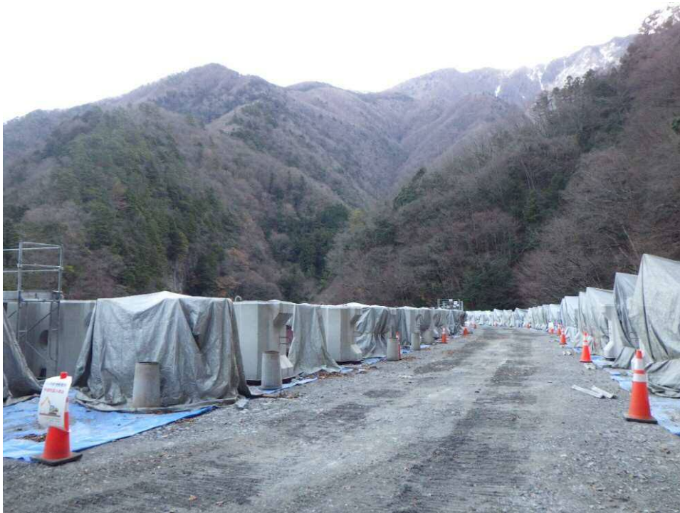
根固めブロック作製
