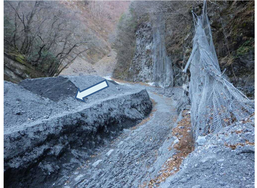
設置箇所掘削状況
