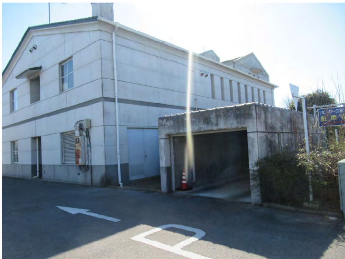
【庁舎 南西面（搬入路より）】
