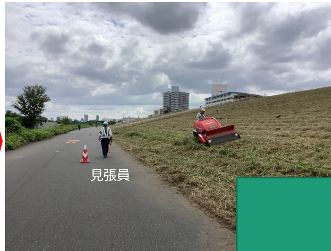
除草時 (河川利用者の安全確保のため見張員配置)
