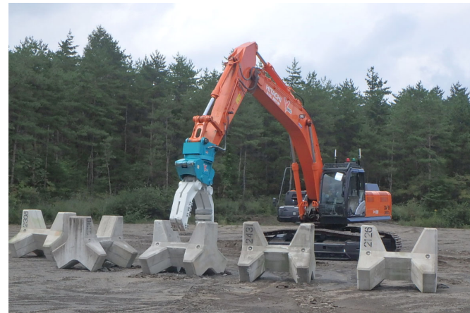
グラップル付バックホウ根固設置(機械)
