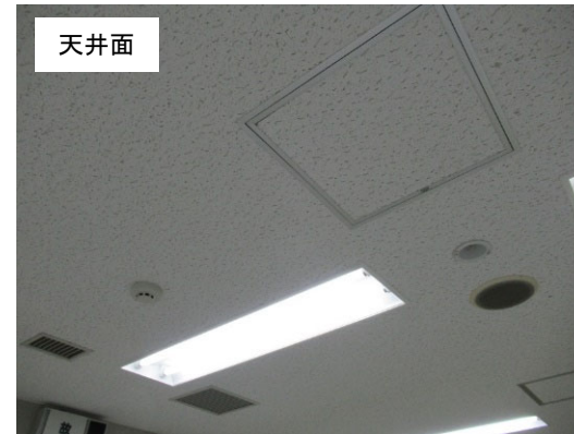
【高層棟12階会議室(4) 感知器設置状況(システム天井部)
