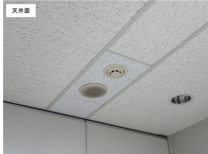
【高層棟12階会議室(4) 感知器設置状況(システム天井部)
