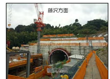
④-2 横浜坑口施工状況(R4.10時点)
