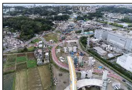
①-3 下部工施工状況(R4.10時点)
