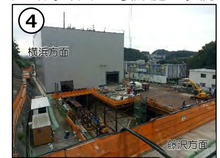
④-1 横浜坑口施工状況(R4.10時点)
