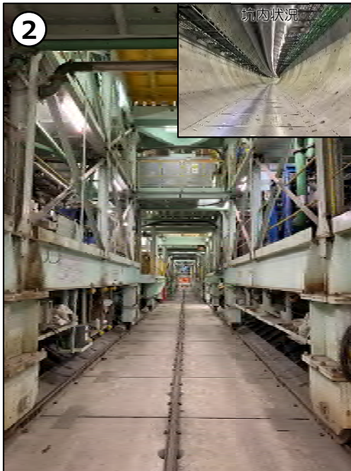
② シールド坑内施工状況(R4.10時点)
