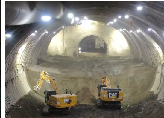
③庄戸トンネル大断面区間 施工状況(R4.10時点)
