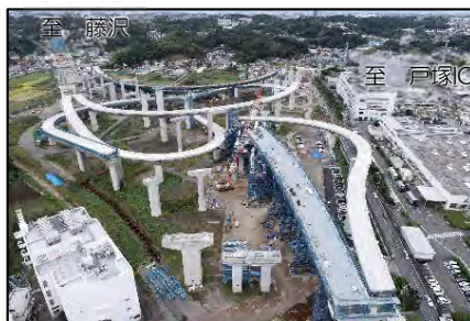
①-2 上部工施工状況(R4.10時点)
