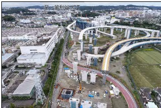
①-1 栄IC・JCT 施工状況(R4.10時点)
