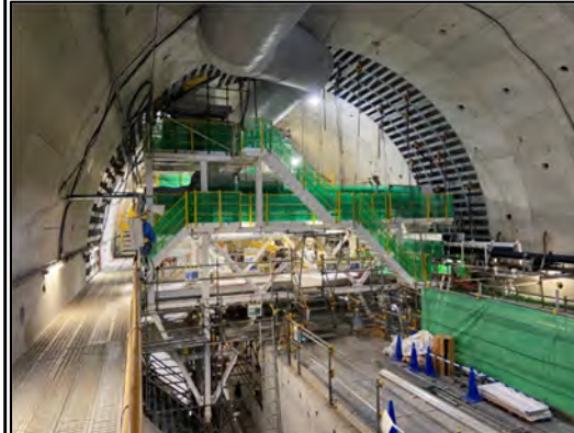
②桂台トンネル坑内 施工状況(R4.10時点)
