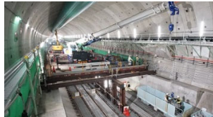
インバート栈橋(坑内作業床)例 東京外環プロジェクトHTPより
