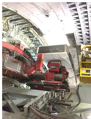
エレクターの油圧駆動化
