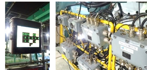
監視モニター(左)・検知器システム(右) 検知器・警報器(2系統) ・切羽、坑口部と坑内100~200mピッチで設置 ・シールド機テール部に設置
