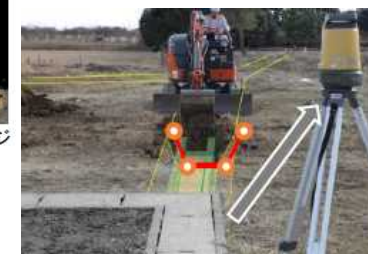
掘削後に据え付けた排水管の点群イメージ
