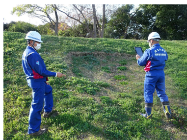
陥没地形の点群データ取得
