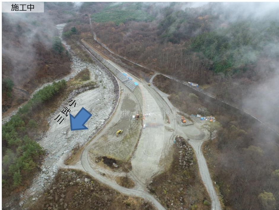
下流側より上流撮影
