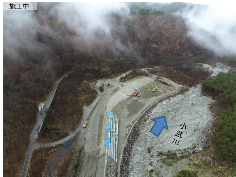
上流側より下流撮影
