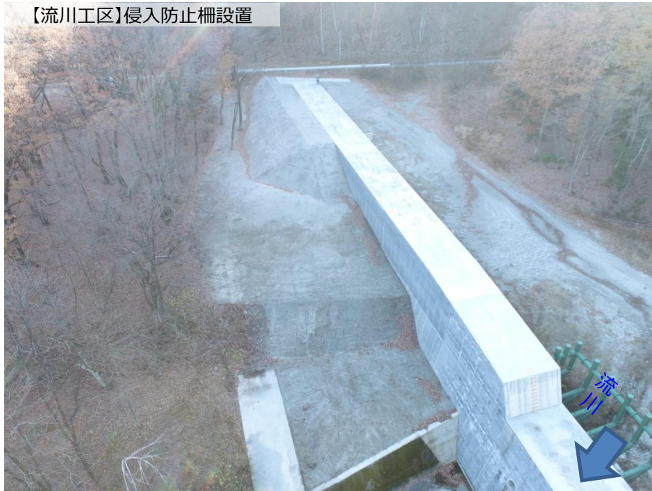
下流側より右岸撮影
