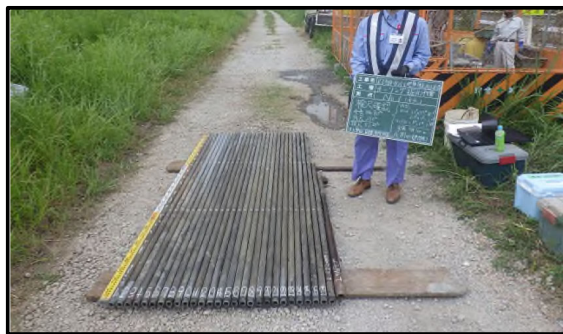
監督職員の現場立会による検尺
