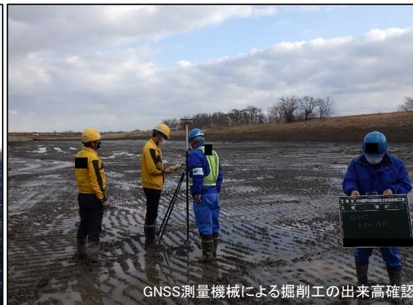
GNSS測量機械による掘削工の出来高確認
