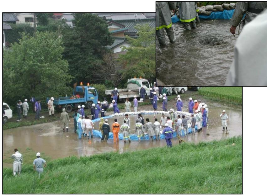
平成13年9月 台風第15に伴う漏水状況 埼玉県加須市大越地先(利根川右岸139k付近)
