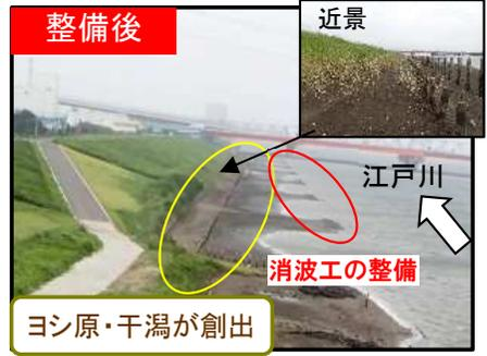
ヨシ原・干潟の侵食を押さえ、ヨシ原・干潟が創出されている。(消波工 H28. 3整備完了)
