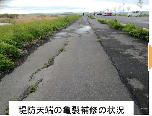
堤防天端の亀裂補修の状況
