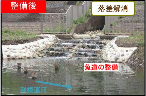
落差を解消し、利根運河における水域の連続性が確保される。(城の越排水樋管 R3. 3整備完了)
