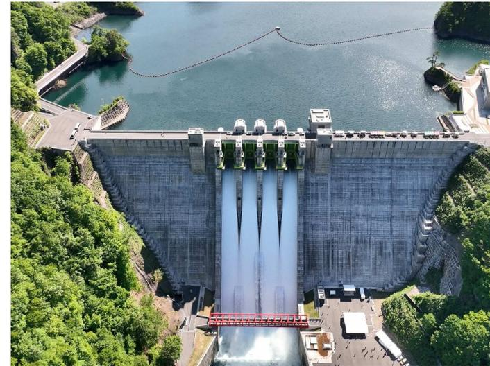
令和元年東日本台風において、試験湛水中であったハッ場ダムは、流入量の約100%を貯留し、平常時最高貯水位に達した。
