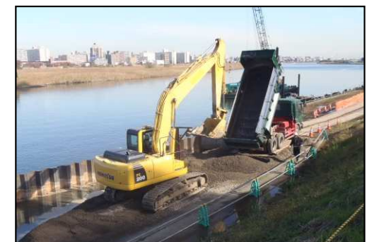
盛土材の搬入状況
