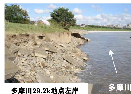
低水護岸の崩落・高水敷洗堀
