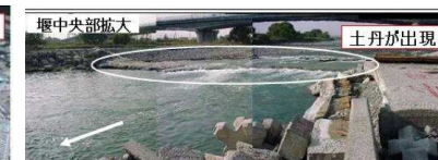
ニヶ領宿河原堰堤左岸側の本堤が決壊したため、堤内地を大きく迂回する濁流
