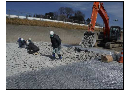
コンクリート殻の利用状況
