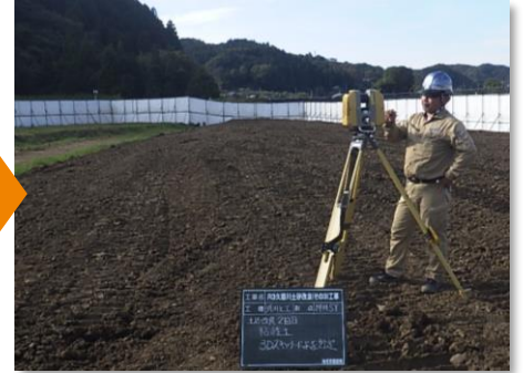
地上型レーザースキャナーによる土量計測
