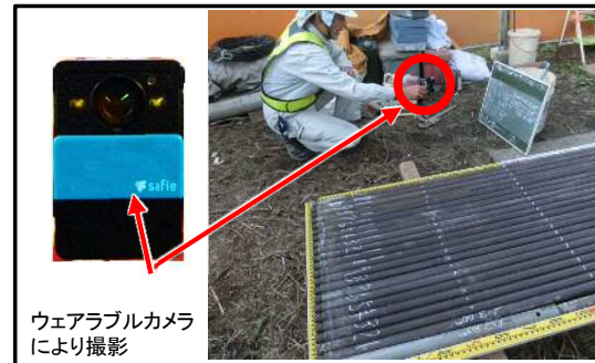
現場での受注者による検尺の撮影
