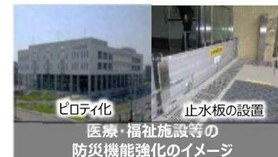
ピロティ化 止水板の設置
