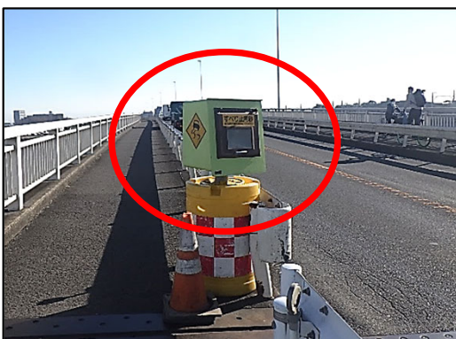
国道1号馬入橋(神奈川県平塚市)
