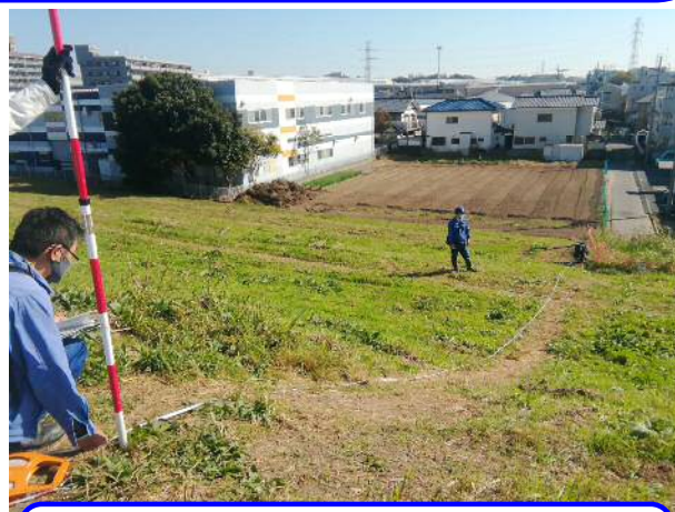
堤防の踏み荒らし→堤防が削られ弱くなってしまいます
