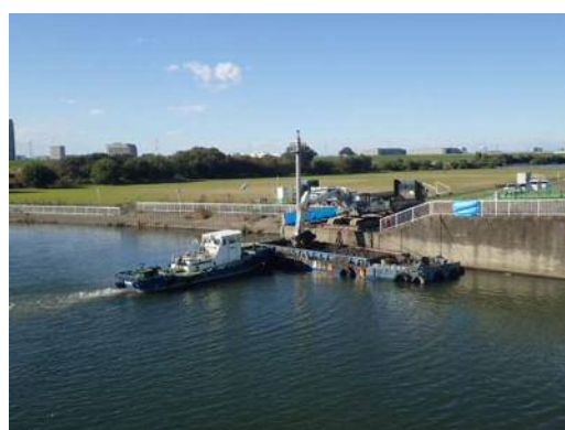
掘削した土砂を台船で陸揚げ
