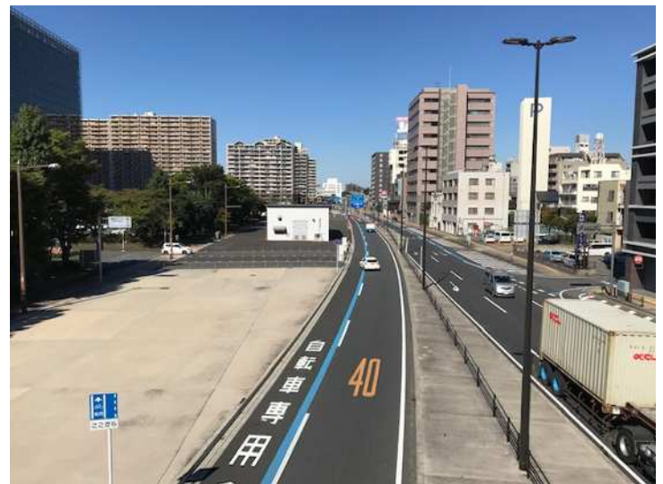
千葉市役所前交差点から東京方面を望む
