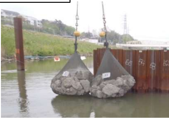
JR水郡線橋梁 撤去ガスを袋詰め根固めとして再利用
