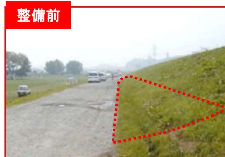
堤防の斜面が利用しにくい
