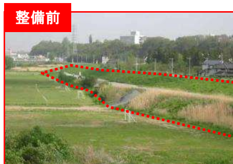
堤防の傾斜が急で利用しにくい
