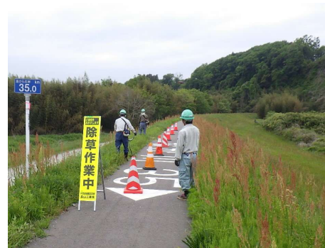
堤防除草作業の状況
