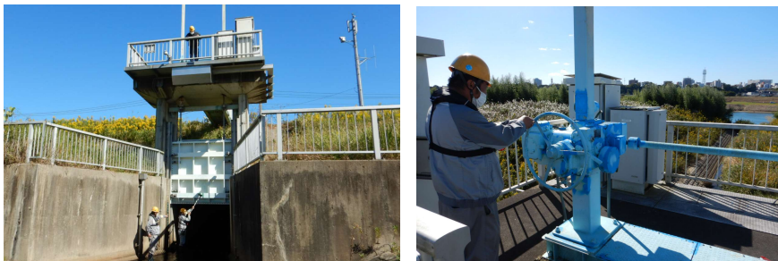
河川管理施設の点検状況
