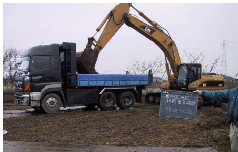
掘削土の積込・運搬
