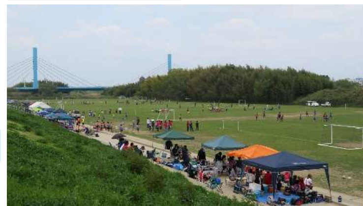
II. 水戸地区(那珂川) 緩傾斜護岸、階段護岸
