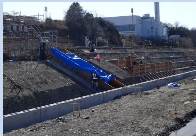
護岸を整備しています。 (令和6年2月)
