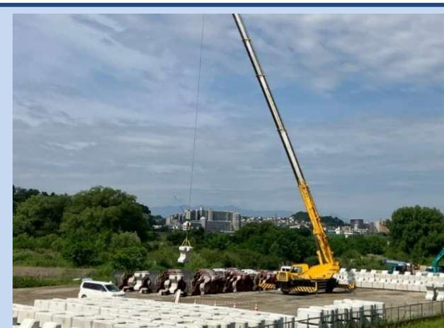
根固めブロックを製作しています。
