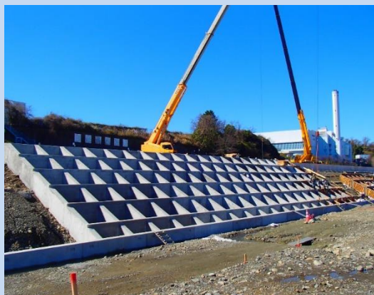
床止めを整備しています。 護岸を整備しています。 (令和6年3月)
