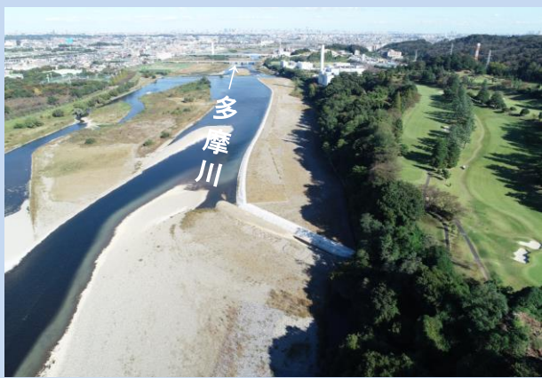
工事着手前(令和4年10月)
