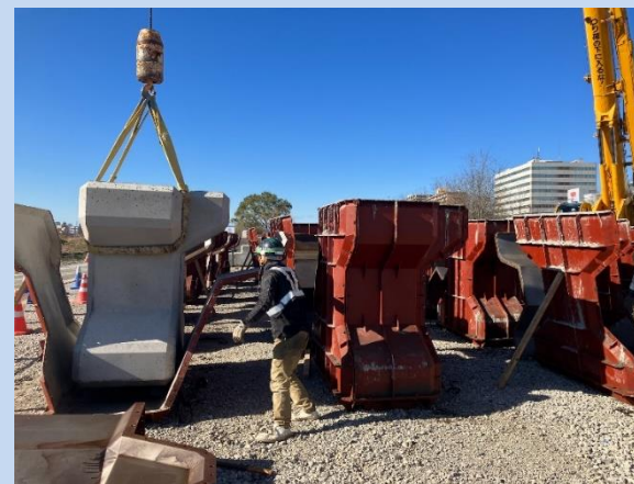
根固めブロックを製作しています。 (令和5年12月)
