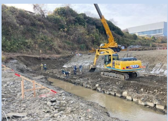
既設の護岸、根固めを撤去しています。 (令和5年12月)
