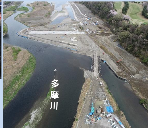
帯工・水路を設置しています。(令和5年3月)
