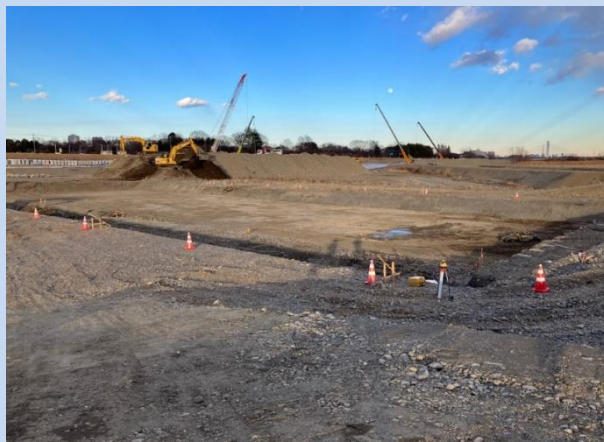
帯工設置のため、床掘りをしています。 (令和6年1月)
