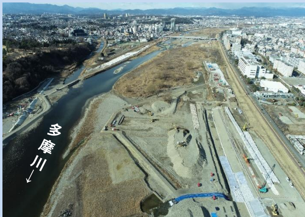
帯工設置のため、床掘りをしています。 (令和6年1月)
