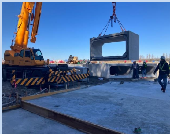
既設の用水堰を撤去しています。 堤外水路を設置しています。 (令和6年1月)
