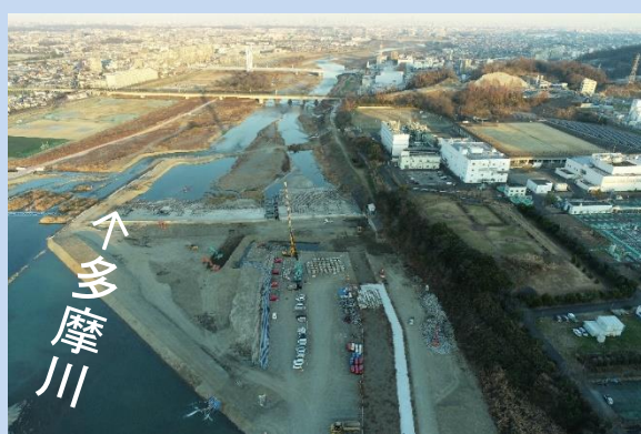
既設の護岸、根固めを撤去しています。 (令和5年12月)
