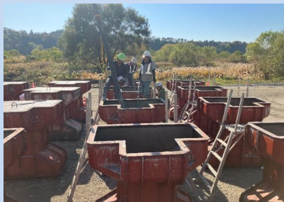
根固めブロックを製作しています。 (令和5年11月)
