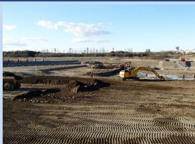
床止めを整備しています。 (令和6年2月)
