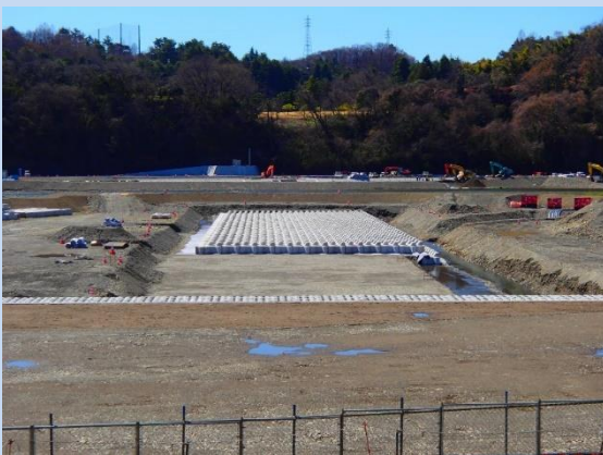
帯工を設置しています。 (令和6年3月)
