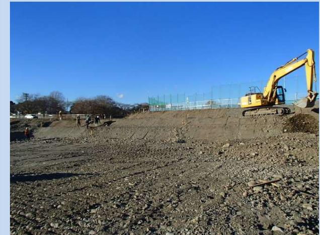
護岸施工箇所の整地を行っています。
