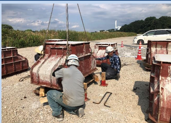
根固めブロックを製作しています。(令和5年7月)
