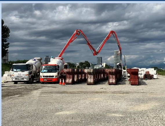
根固めブロックを製作しています。(令和5年10月)
