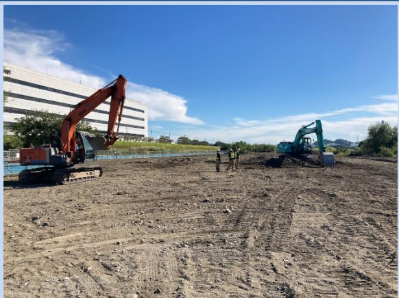
根固めブロック製作ヤードを 造成しています。(令和5年10月)
