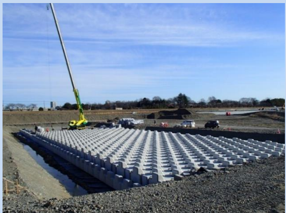
根固めブロックを設置しています。 (令和6年2月)
