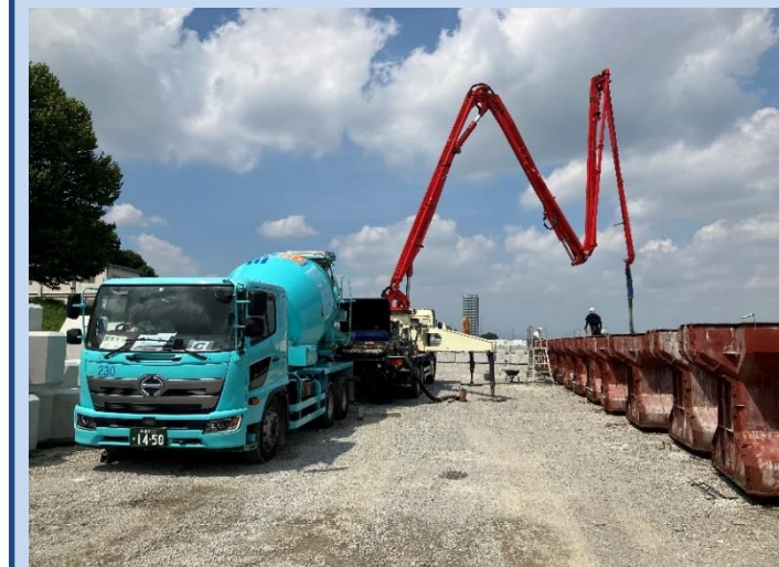
根固めブロックを製作しています。 (令和5年8月)
