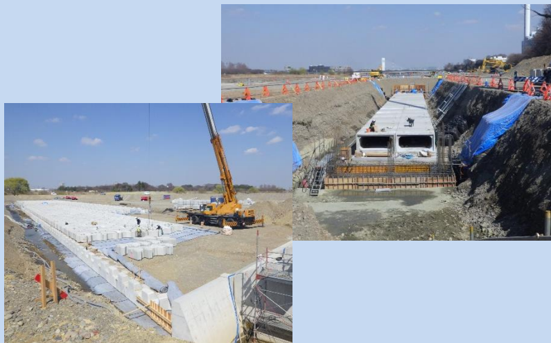
帯工・水路を設置しています。(令和5年3月)
