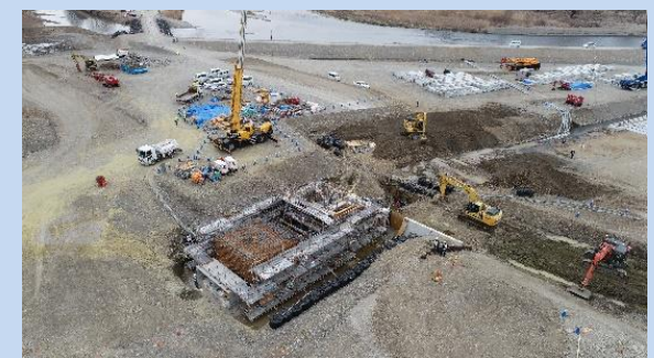
帯工・取水施設を設置しています。 (令和5年2月)
