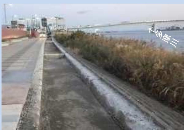
平場の整備をしています。 (令和4年12月)
