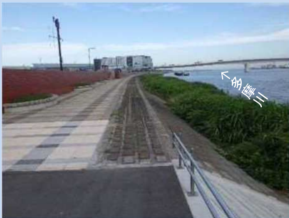
工事着手前 (令和4年10月)
