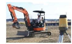
床堀などの出来形計測の必要がない作業は小型建機+MGで行い低コスト化
