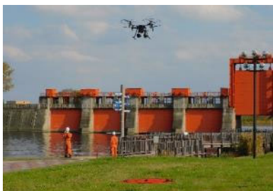
ドローンにより上空から被災状況を調査
