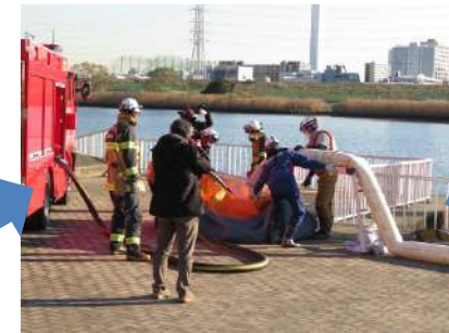
排水ポンプ車による受水槽への送水、消防車による給水
