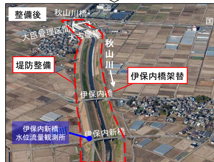
秋山川 伊保内橋の架替と新堤の整備
