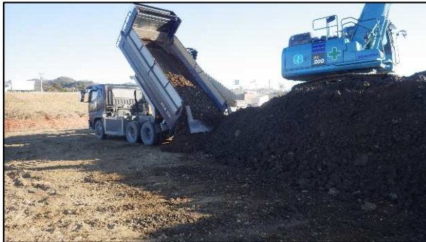
建設発生土の受入状況（緑橋ヤード）
