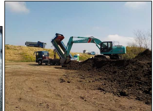
建設発生土の受入状況（高橋大橋下流ヤード）
