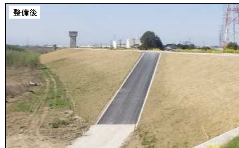
渡良瀬川 高取地区 堤防強化(R2.3完成)
