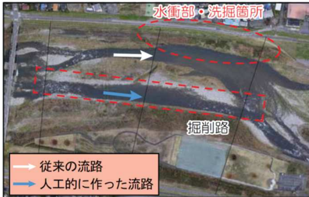
中州の筋掘り(掘削路)による浸食・洗掘対策
