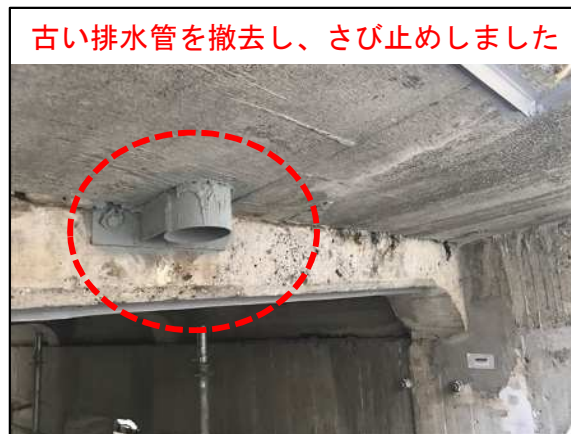
排水管の補修状況（代表写真）
