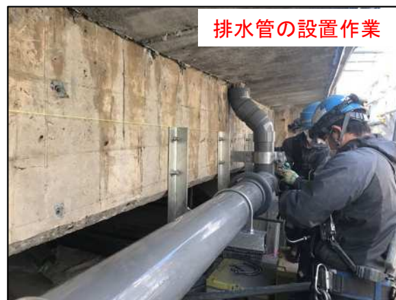
排水管の補修状況（代表写真）
