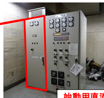
始動用直流電源盤 (蓄電池含む)の更新
