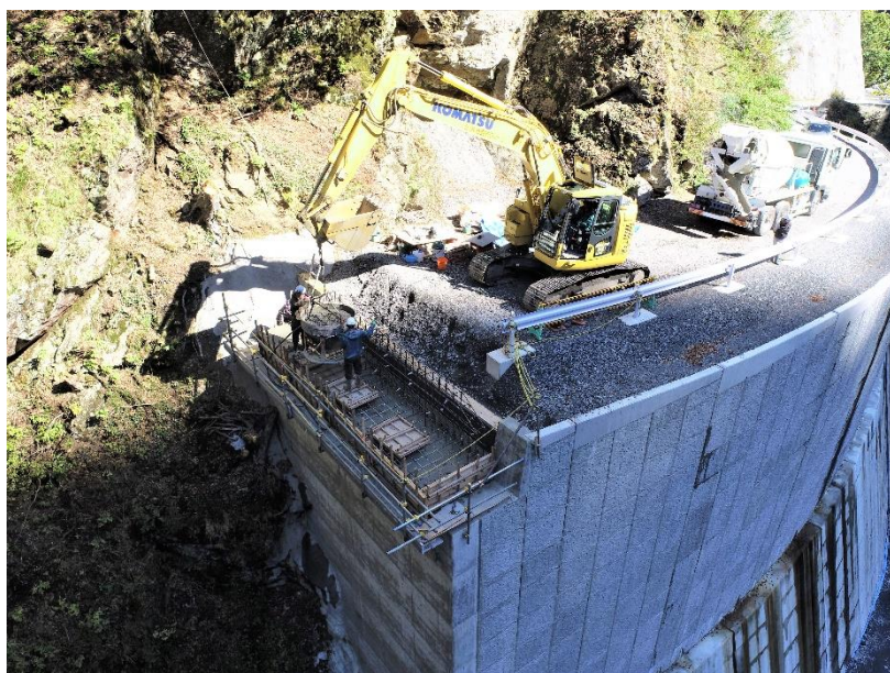
【橋台施工状況】
