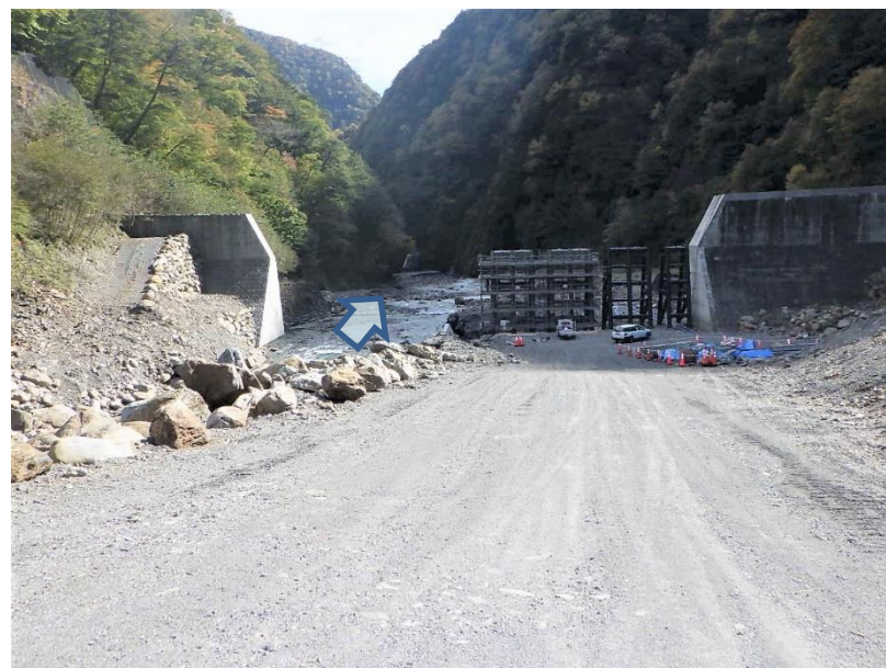
【上流側より施工箇所を望む】
