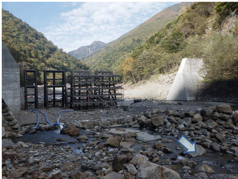
【下流側より施工箇所を望む】
